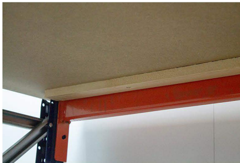
Vullat onderzijde gemonteerd
